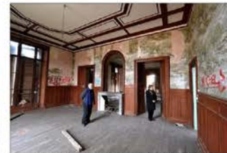
L'immense double miroir, installé à l'origine entre deux salons, a disparu.
